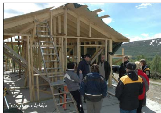
Befaring på ny mjølkestall på Jaslangen
